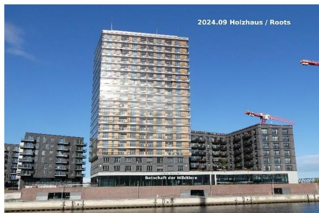
Das Bauwerk besteht aus einem 19-geschossigem Hochhaus und einem östlich daran angrenzenden siebengeschossigen Riegel, eine **Holzkonstruktion** mit aussteifendem Stahlbeton-Treppenhaukern.
